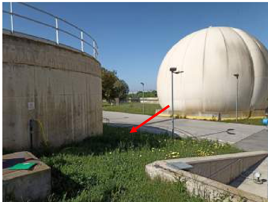
Figura 15. Ubicació del contenidor de descàrrega de sòlids retinguts
