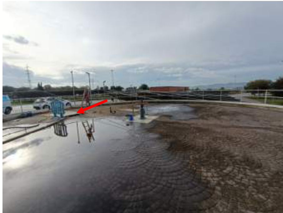
Figura 6. Accés actual a l'espessidor (1)
