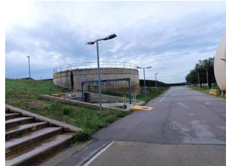
Figura 4. Vista lateral de l'espessor i zona d'implantació de nous equips
