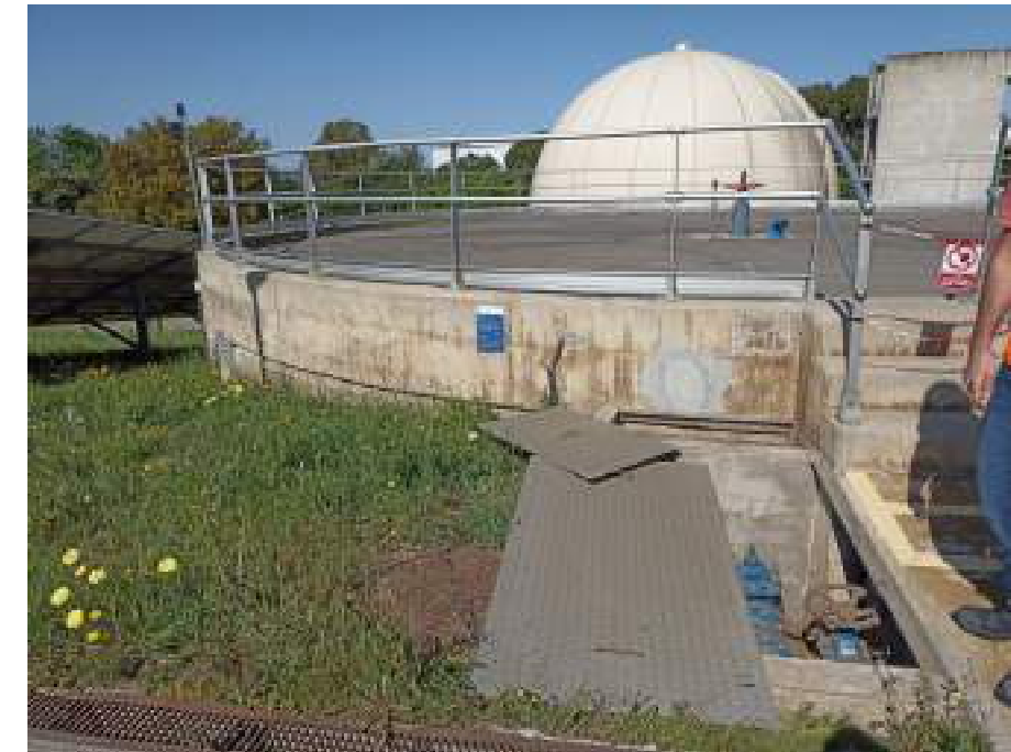
Figura 1. Vista exterior de l'arqueta de by-pass actual
