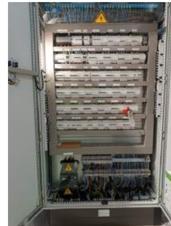
Figura 25. Interior del quadre de màquines (punt de connexió del nou CCM de rehidratació)
