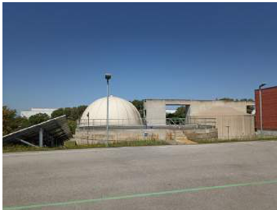
Figura 3. Vista del espessor des de la carretera d'accés, futura zona de descàrrega de fangs
