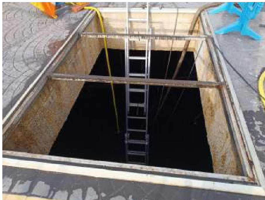
Figura 7. Accés actual a l'espessidor (2)
