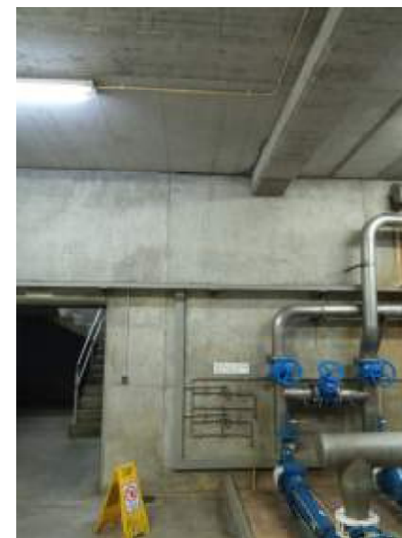
Figura 21. Zona muntant canonada fangs de rehidratació cap a la planta 0
