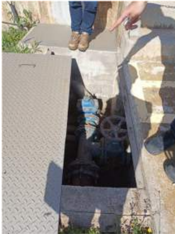
Figura 2. Vista interior arqueta de by-pas actual
