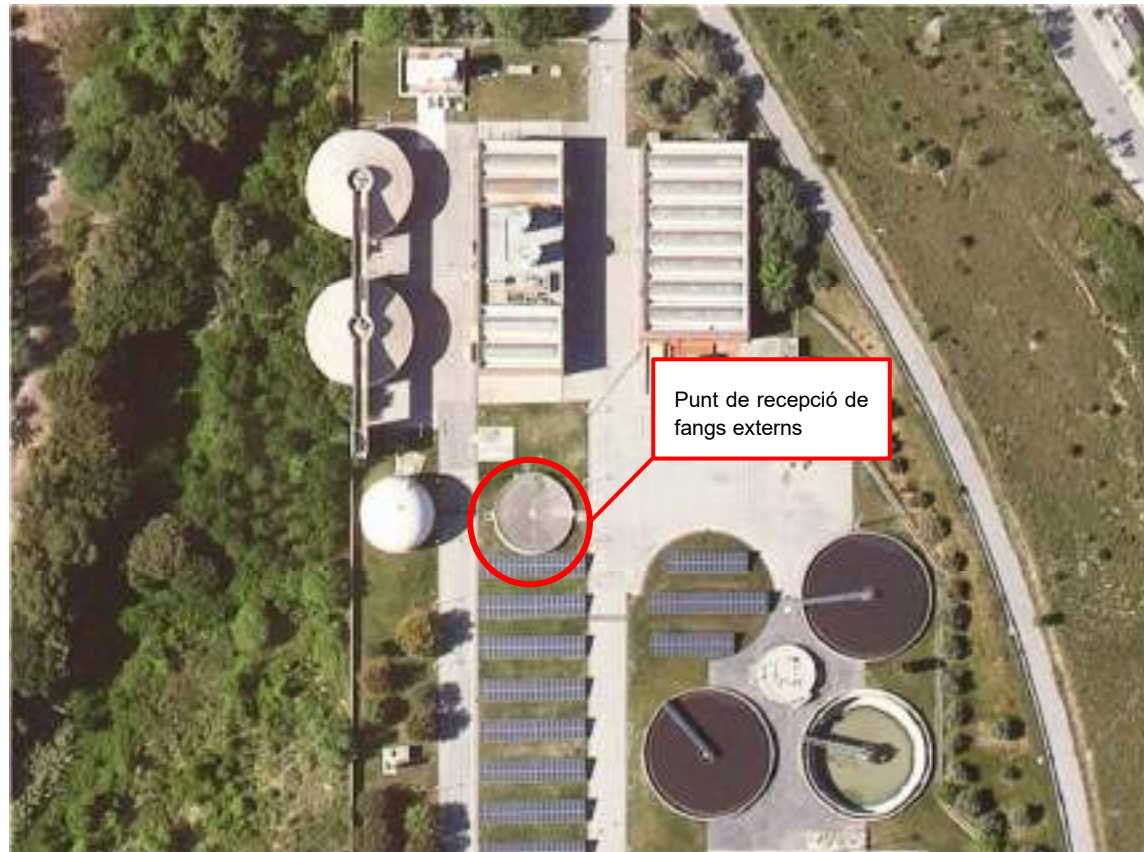
Figura 2: Punt reservat per a la recepció de fangs externs
